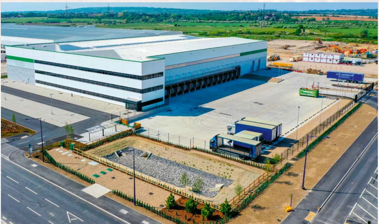
La nouvelle centrale ZIEGLER au Royaume-Uni.
