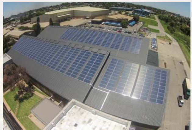
Panneaux solaires sur le toit de l'entrepôt de Johannesburg.
